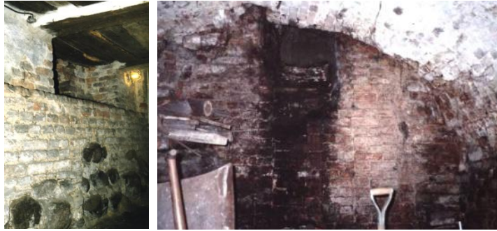
Ryc. 36. Ul. Szkołna 1. Wejście do piwnicy. Ściana od strony ul. Szkołnej. Fot. M. Szajerka.
