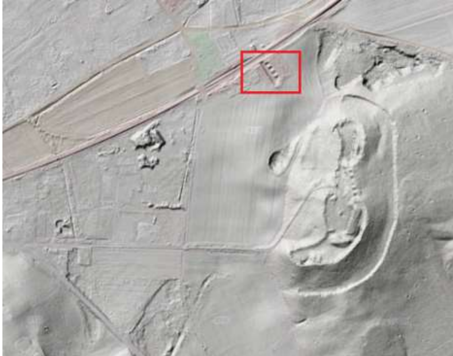
Bateria kolejowa, fort Mała Ksieża Góra.
